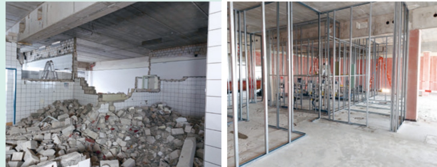
Abriss- und Neubauarbeiten im Bildungszentrum.
