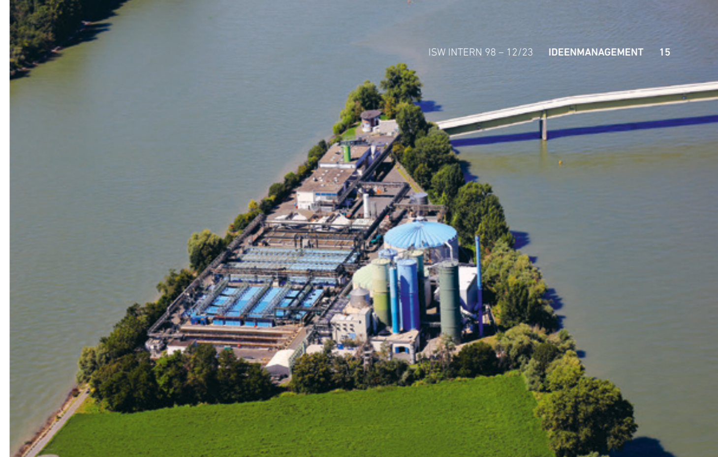
Die Biologische Abwasserreinigungsanlage (BARA) des Industrieparks auf der Petersaue.
