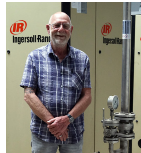
Klaus Hoffmann vor dem BARA-Betriebsgebäude, in dem Druckluftverdichter untergebracht sind, auf deren energieintensiven Betrieb zukünftig weitgehend verzichtet werden kann.
